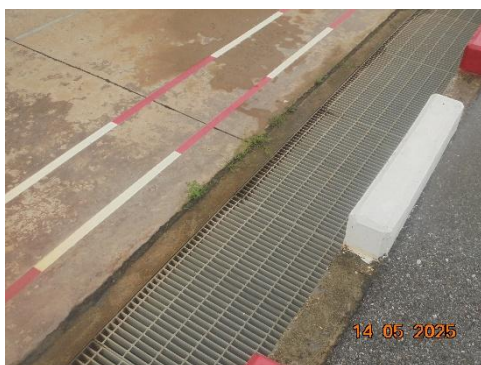
ภาพที่ 2.2-19 รางระบายน้ำฝนที่อาจปนเปื้อน
