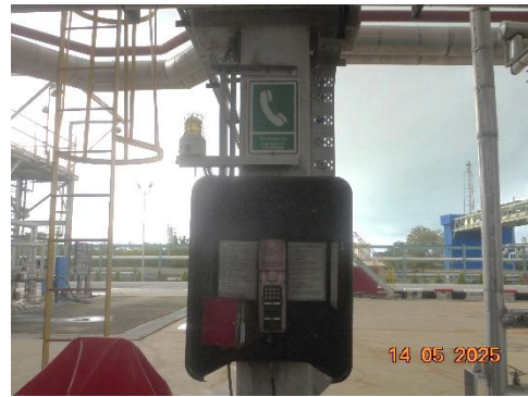
ภาพที่ 2.2-42 ติดตั้งอุปกรณ์แจ้งเตือนกรณีเกิดเหตุฉุกเฉิน
