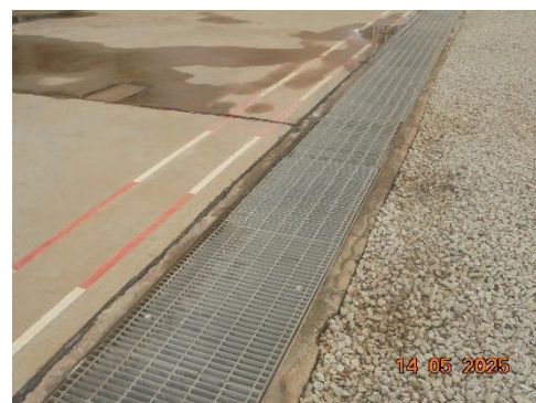
ภาพที่ 2.2-19 รางระบายน้ำฝนที่อาจปนเปื้อน
