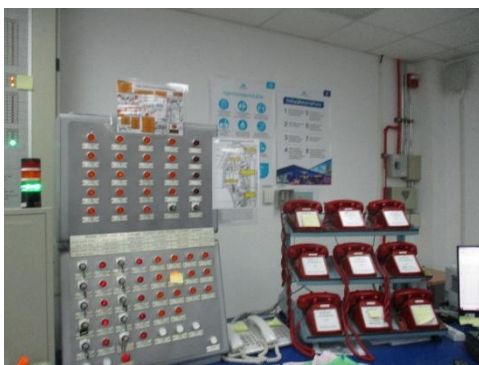
ภาพที่ 2.2-44 ศูนย์เฝ้าระวังและอุปกรณ์แจ้งเหตุฉุกเฉินในห้อง Control Room
