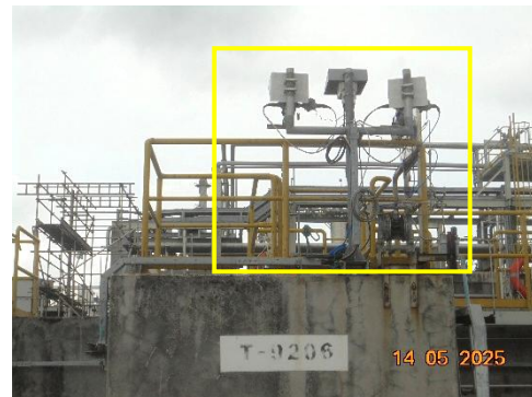
ภาพที่ 2.2-14 การติดตั้งเครื่องตรวจวัด pH และ Conductivity Online
