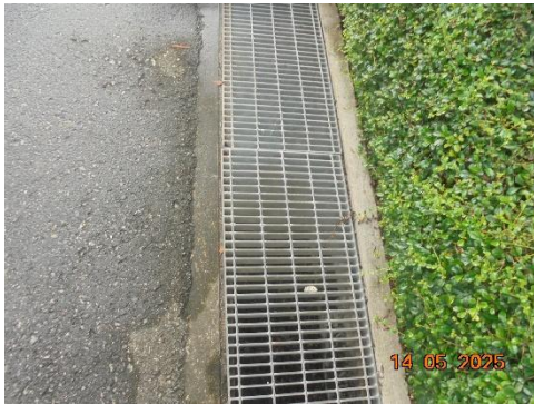
ภาพที่ 2.2-20 รางระบายน้ำฝนโดยรอบส่วนอาคาร
